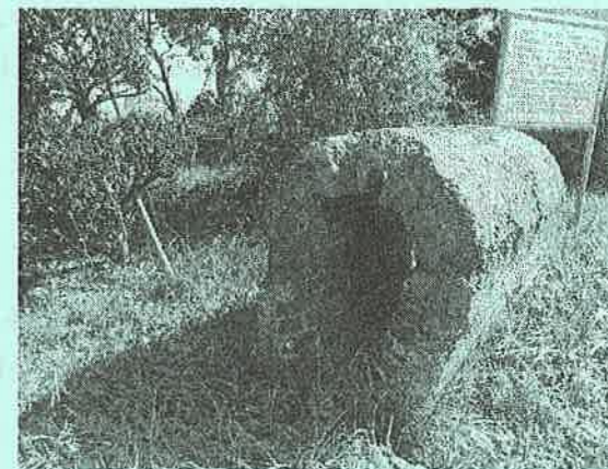
日本で最初の下水道管
