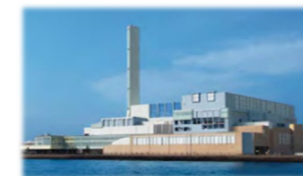
工場の新設・長寿命化工事
