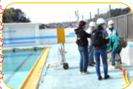
プールから送水ポンプ操作
