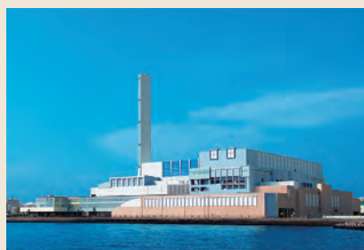
焼却工場の長寿命化
